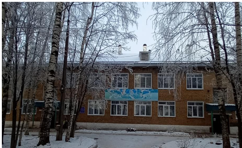
Корпус 1 по ул. Тентюковская, д. 505/1
