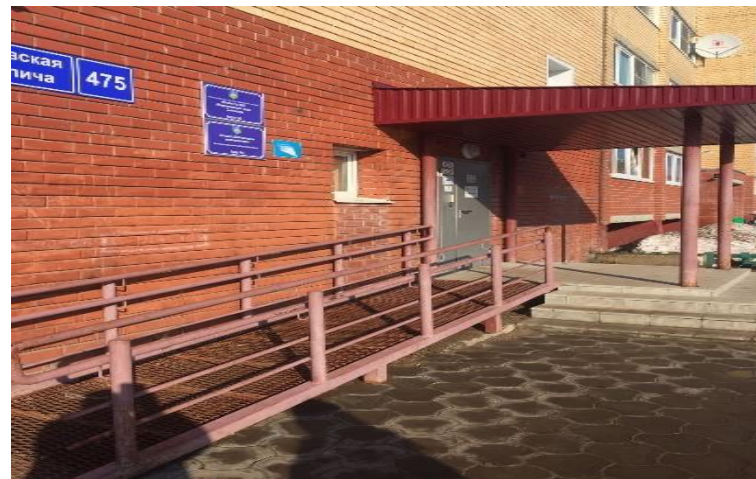
Корпус 2 по ул. Тентюковская, д. 475
